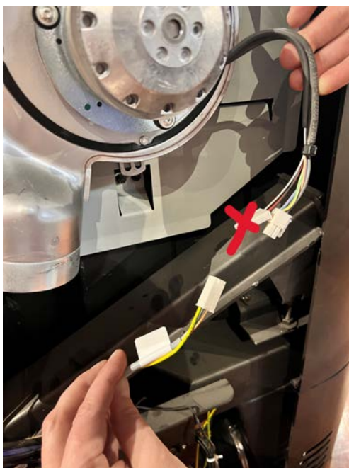
Fig. 23: Raccorder les câbles
