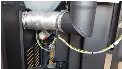
Abb. 78: Aluflex-Schlauch anbringen.
