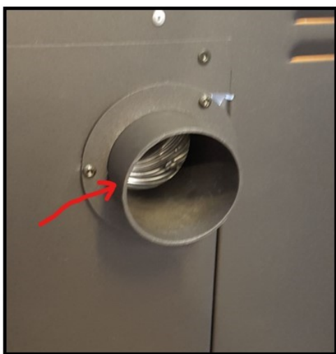
Abb. 81: Doppelanschlussstutzen montieren
