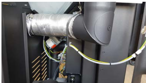
Fig. 78: Poser le tuyau flexible en alu.
