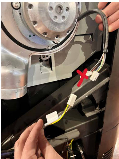
Fig. 72: Raccorder les câbles
