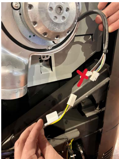
Fig. 59: Raccorder les câbles
