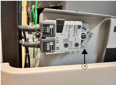
Fig. 44: Smontaggio del motore della griglia ribaltabile
