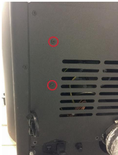
1) Sulla parete posteriore della stufa sono stati predisposti 2 fori sul lato destro con viti ISK (a esagono incassato) M4 x 8 per il montaggio del WiRCU-Box. Queste viti devono essere svitare con una chiave a brugola da 2 mm prima dell'installazione.
