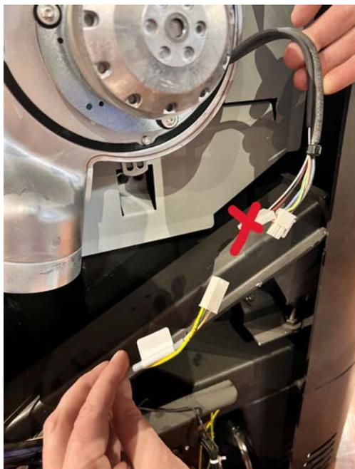
Fig. 23: Raccorder les câbles
