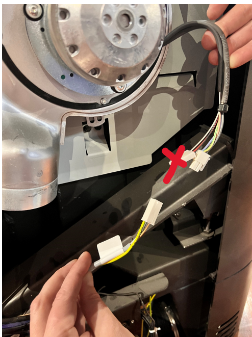
Fig. 23: Raccorder les câbles
